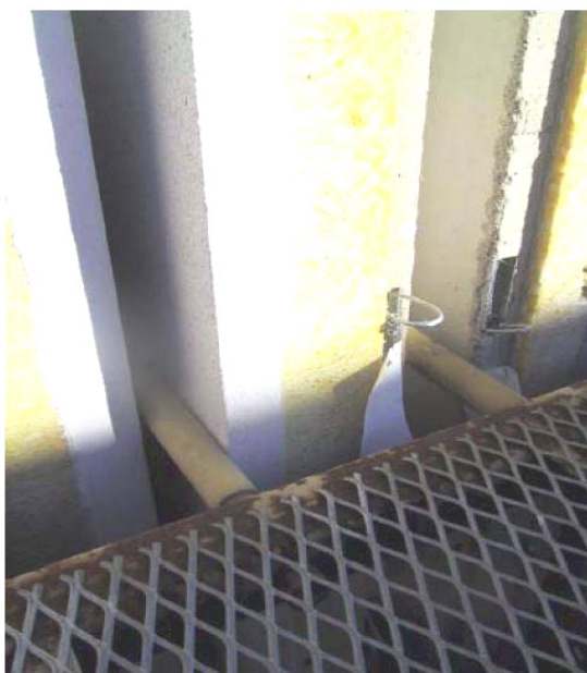
Paveikslas. Nr.3 Sandėliuojamų sienų įtvirtinimas. Atkreipti dėmesį, kad pleištai padengti netepančia, vandens neįgeriančia medžiaga!
