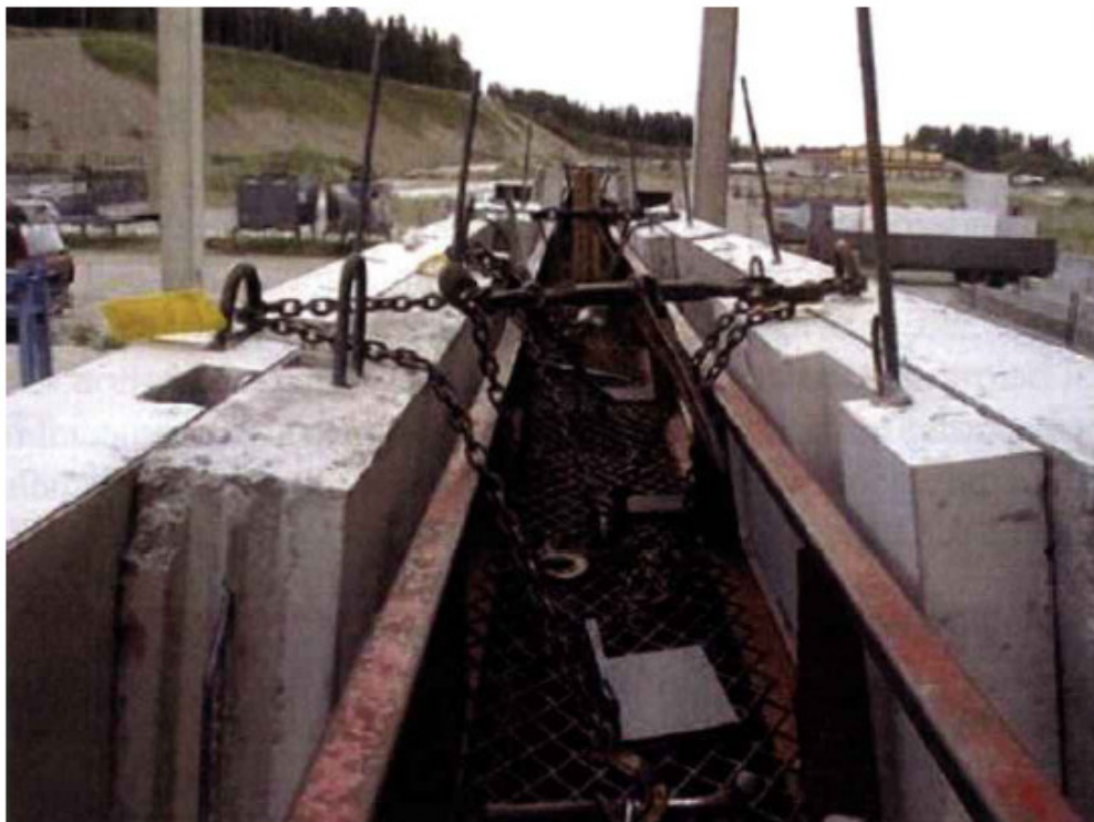
Рис. 4. Однослойные стеновые панели установлены и скреплены в форме пирамиды
