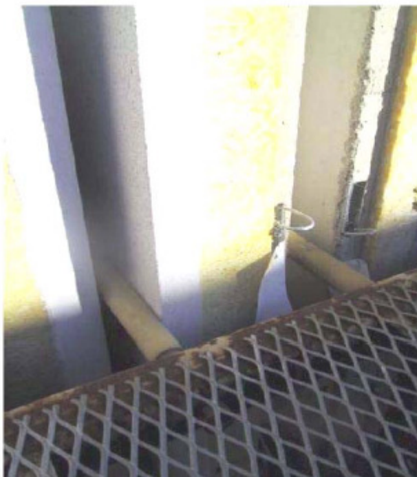
Рис. 3. Крепление складываемых стеновых панелей. Обратите внимание, что поверхности клиньев покрыты немарким, водонепроницаемым материалом!
