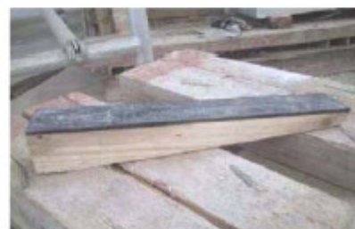
Рис. 3. Крепление складываемых стеновых панелей. Обратите внимание, что поверхности клиньев покрыты немарким, водонепроницаемым материалом!
