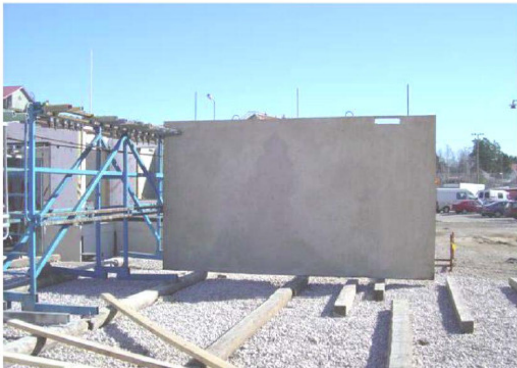
Рис. 2. Складирование стеновых панелей. Обратите внимание на размеры брусьев!
